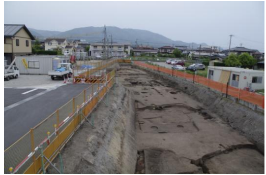
1 区 調査区全景
