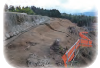
斜面に築かれた平場
