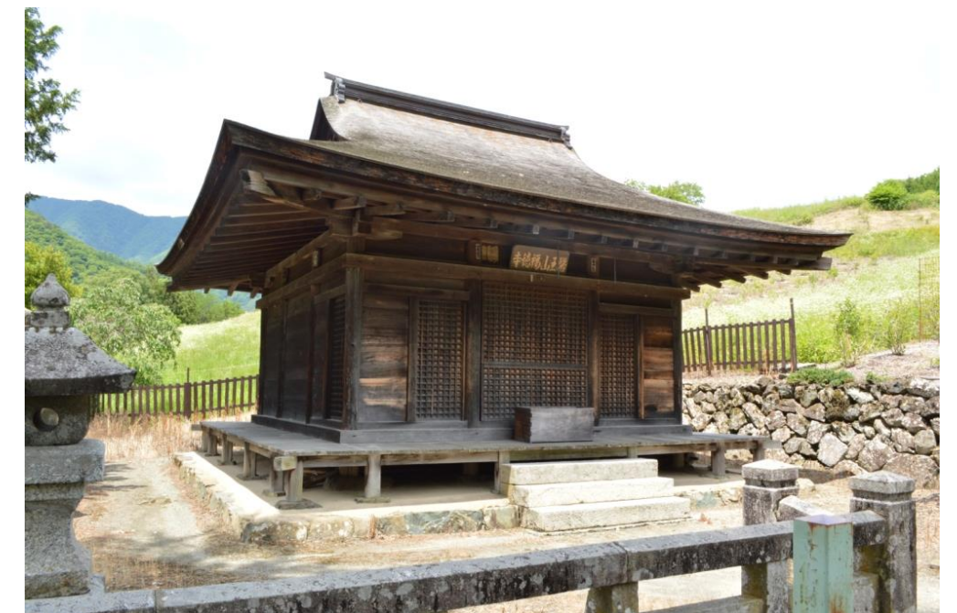
国重要文化財 福德寺本堂（大鹿村） 今回発見された礎石建物跡は、写真のような建物であったと考えられます。現存する中世の仏堂で、桁行3間、梁行3間の建物です。明治45年に室町時代前期の建物として国の重要文化財に指定されました。(撮影 河西克造)
