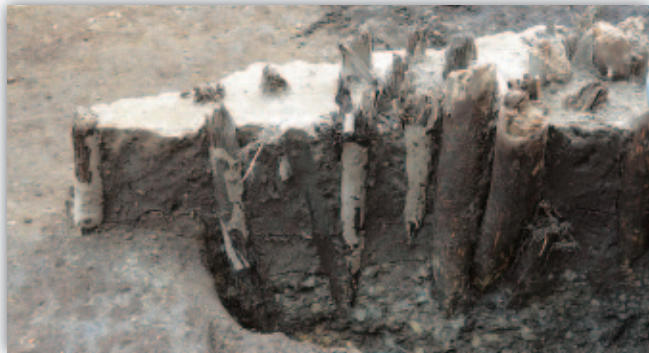
江戸時代の地業（基礎工事）
