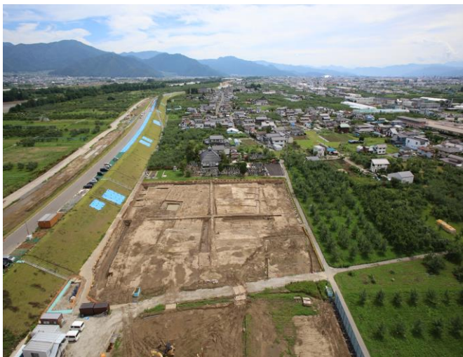
令和6年度調査区空撮（北から撮影）
