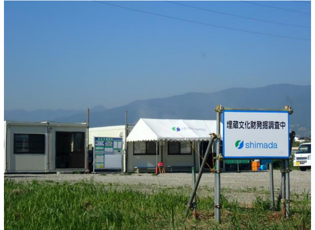
現場に設置したプレハブ
