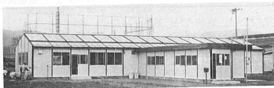
松塩筑調査事務所の開設(第1次建設分)
