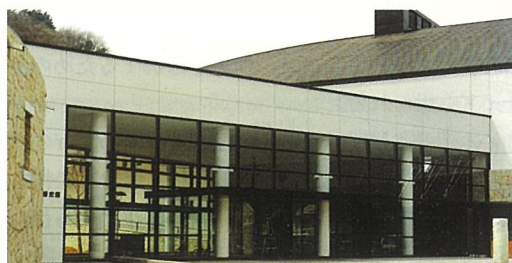
正面玄関入口付近
