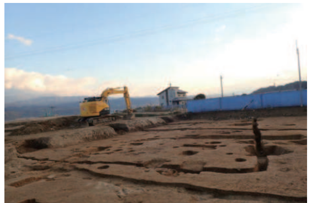
図60 B-2区 SD309（北西から）
