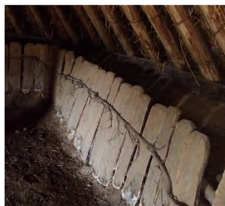
【参考】左：むき出しの壁の上に垂木を刺している 中：壁の土留めに板を並べている 右：壁の土留め板を杭で留めている
