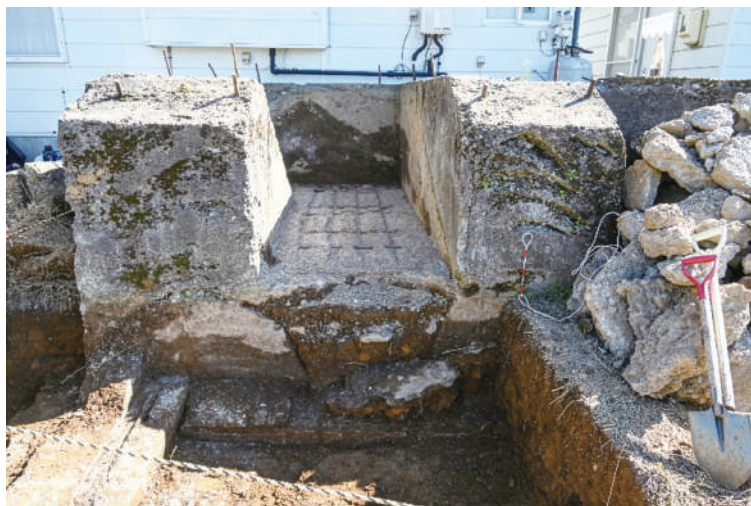
試掘調査で判明した第二格納庫の基礎
