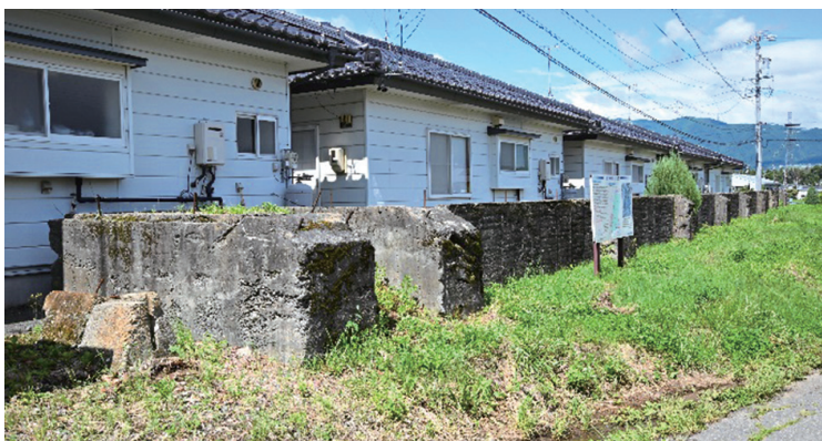
現存する格納庫のコンクリート基礎
