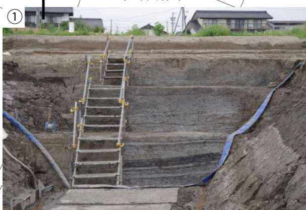
現地表面から6mの深さで堀の底を確認しました
