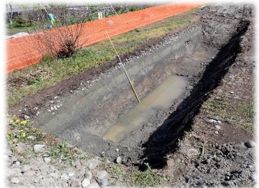
11区 トレンチ断面
