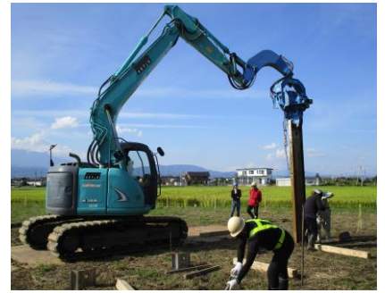
ジオスライサーの打ち込み作業
