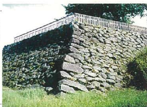
松代城跡 本丸戌亥隅櫓台の石垣。野面(のづら)積みで積まれた石垣で、城内で最も古い
