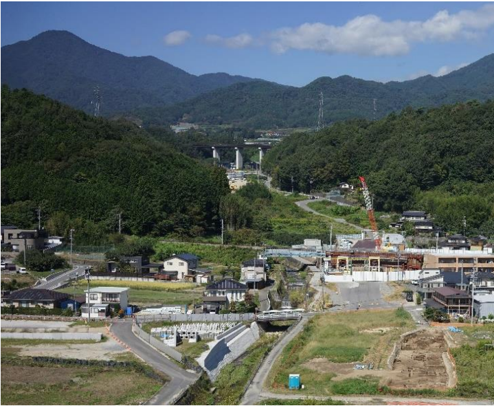
正泉寺遺跡全景（東側から撮影）
