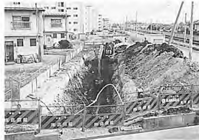
第65図 重機によるトレンチ掘削
