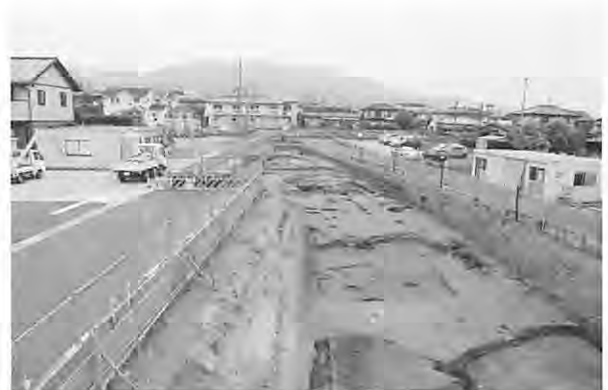
図 5 1 区（北側調査区）全景 南から
