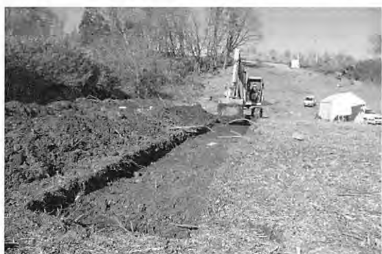
図48 トレンチ掘削状況
