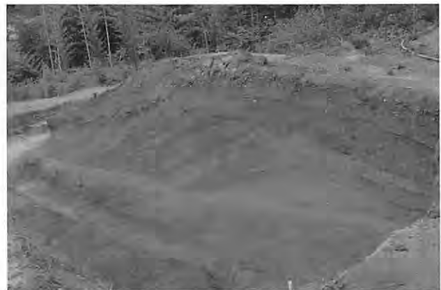
図52 調査地北西の盛土の状況
