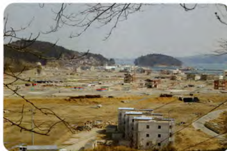
南三陸町志津川地区(平成24年3月)
