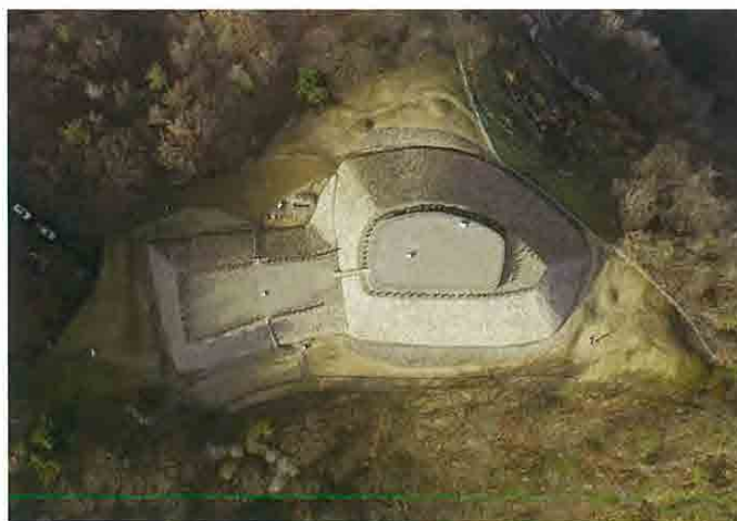
補修後の古墳全景（右上が北）
