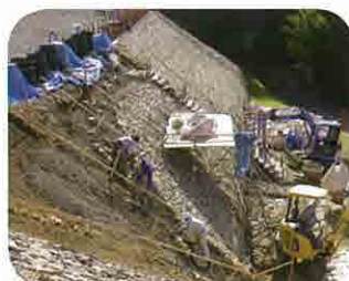
前方部西側〜くびれ部葺石積み直し
