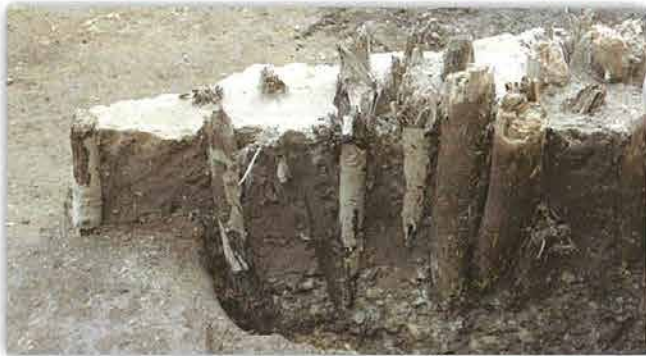
江戸時代の地業（基礎工事）
