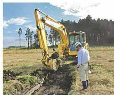
萱浜工業団地予定地の試掘調査
